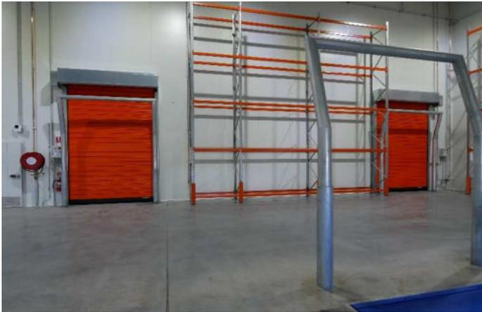
Las puertas de accionamiento rápido FREEZ 1 & 2 han sido especialmente diseñadas para su uso en celdas de enfriamiento y congelación y, además de ser las más adecuadas a tal efecto, funcionan sin problemas en el congelador. La alta velocidad de apertura y cierre y el sellado superior limitan las fluctuaciones de temperatura, reducen la entrada de humedad al congelador y optimizan el transporte interno.
